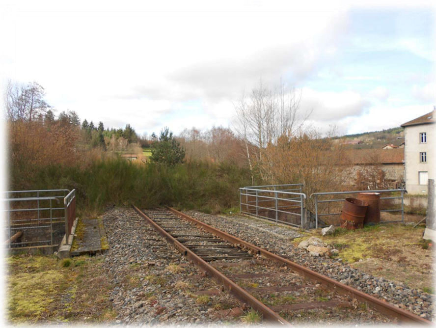
Plateforme de la ligne Saint-Etienne-Clermont-Ferrand, dans la montée depuis Boën vers Noirétable. La direction de Clermont-Ferrand est au fond.
