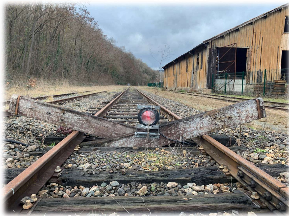
Traverses en croix à la sortie de la gare de Boën. La direction de Clermont-Ferrand est au fond.
